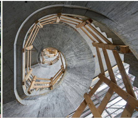
Wendeltreppe vom Haupteingang bis ins Geschoss 5
